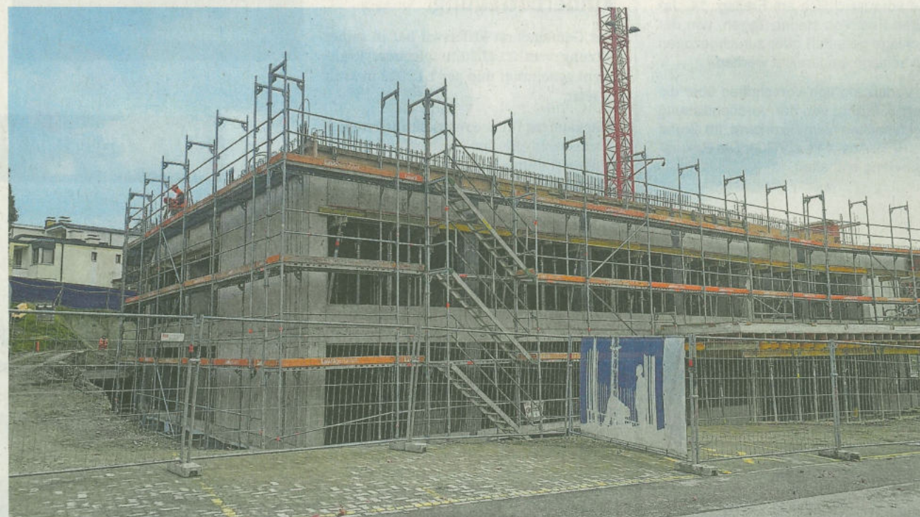
Aktuell wird die Decke des Erdgeschosses betoniert. Das Gebäude hat später vier Obergeschosse. (Bild Livia Häberling)
