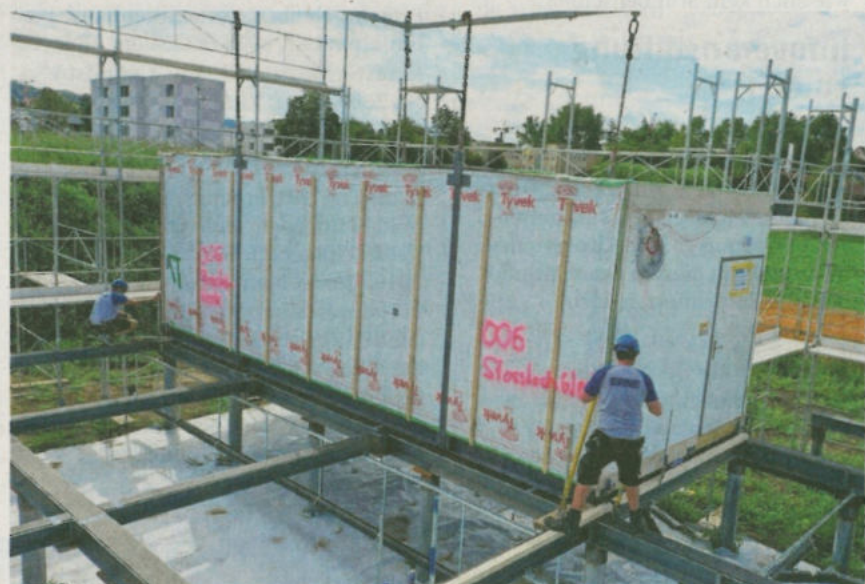
Insgesamt werden 102 Holz-Stahl-Module montiert.
