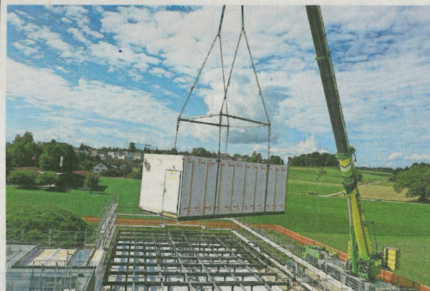
Ein Pneukran bringt die bis zu 16 Tonnen schweren Module in Position.
